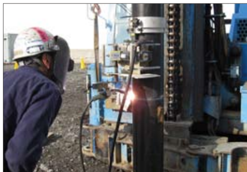
茨城県土浦市某工場での施工の様子、足元の悪さに左右されません
