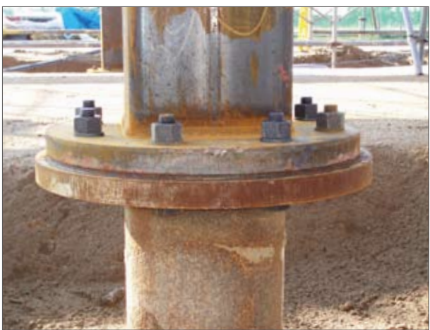
杭と柱を直接接合
