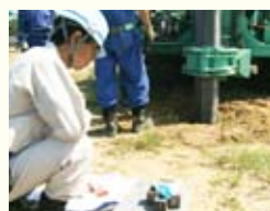
下杭貫入の様子
