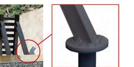
ECS-TP工法は、短時間で杭を打ち込むことができるため、工期も設置資材も大幅に削減できるものになっています。
