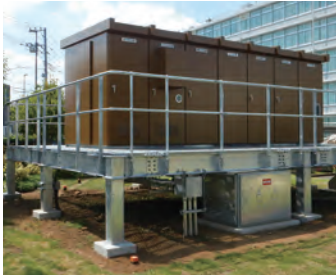
(上下写真共に) コンクリートを排し工期短縮を実現した鋼製架台
