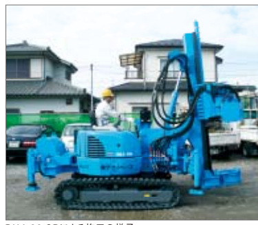
DHJ-06 SPによる施工の様子
